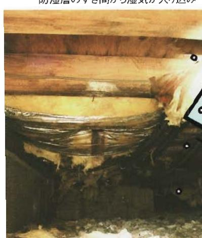
袋入りグラスウールの正しい施工法は、すべての施工者が熟知しているとは言い難い。室内側のフィルムと室外側のフィルムの違いなどは、あまり分かっていないようだ。当社ではグラスウール断熱施工のマニュアルを用意して、現場の職人に説明の上、記入してもらっている。以前は間柱の見込み面にタッカーを打つ人がほとんどだったが、今は見附け面にきちんと取り付けられている。ただ、**横胴縁の取り付けや筋かいによって、現場ではきれいに納まらないのが悩みだ。**フィルムの切れた個所や損傷した部分のテープ止め、通気層を確保するのはもちろんだが、これからは筋かいをやめて耐力壁面材をメインに使っていこうと思っている。（高橋友也さん、TOMO設計コンサルタント）
